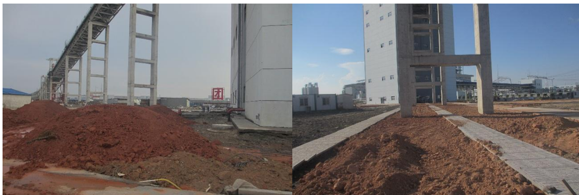
输煤栈桥下覆土
