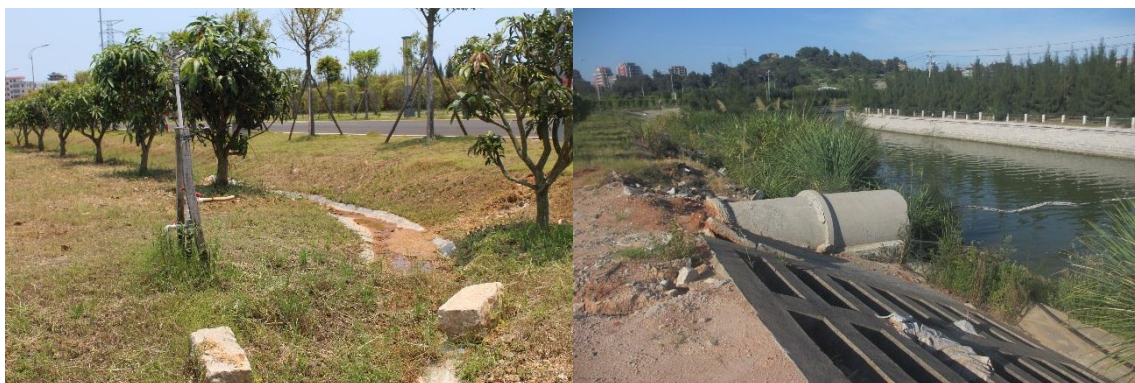
厂外道路侧排水土沟
