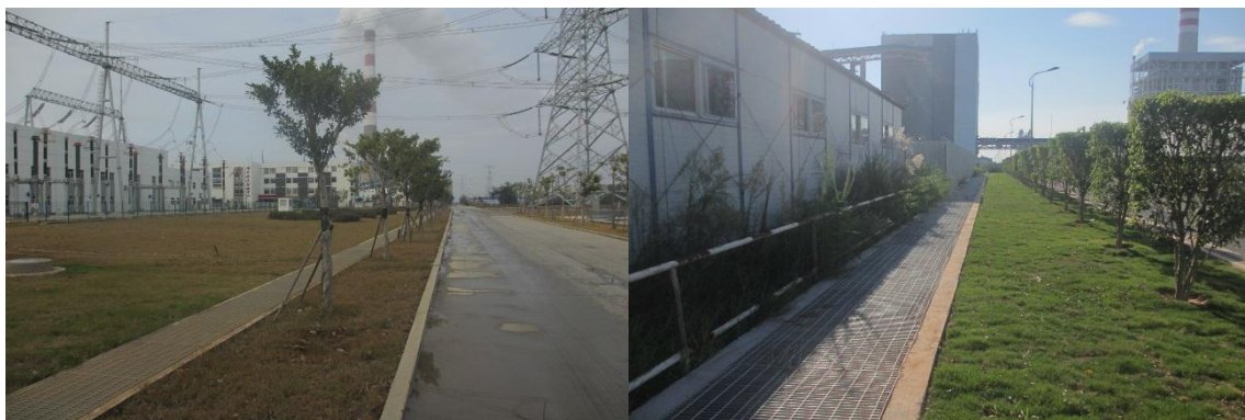
厂内道路两侧排水土沟
