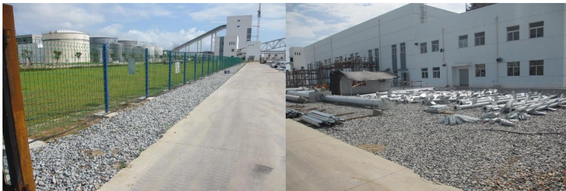
砾石盖压防护
