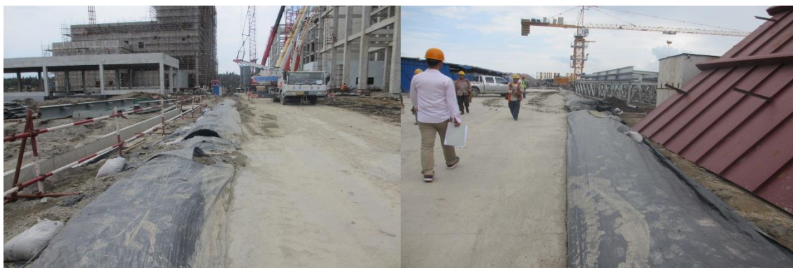
开挖土方土工布临时覆盖
