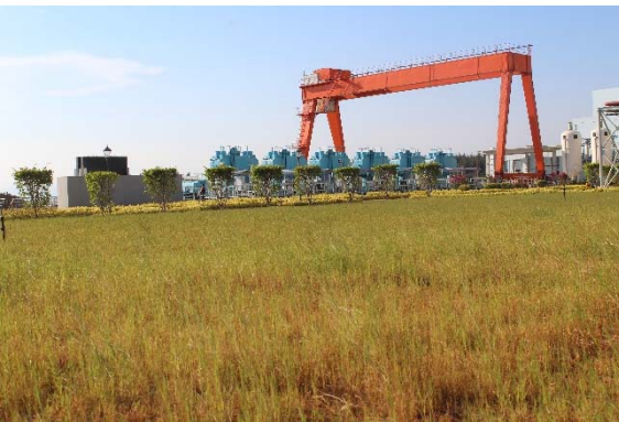
厂区撒播草籽绿化
