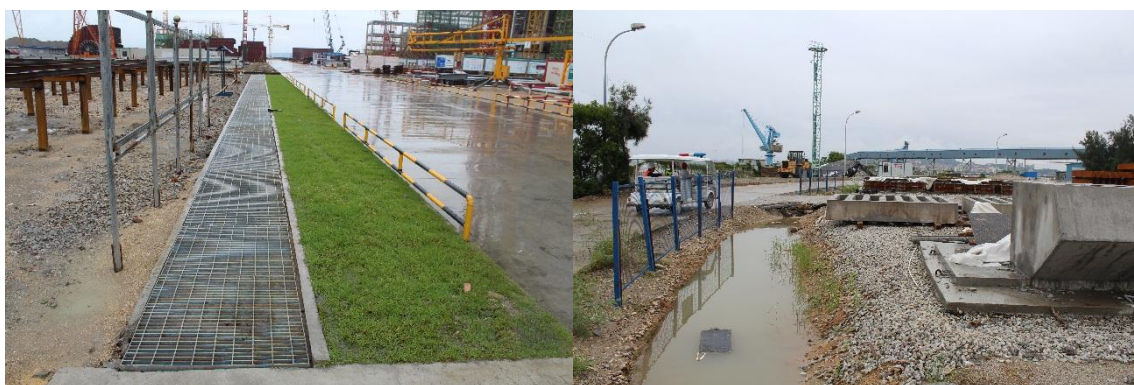
厂区钢筋混凝土排水沟
