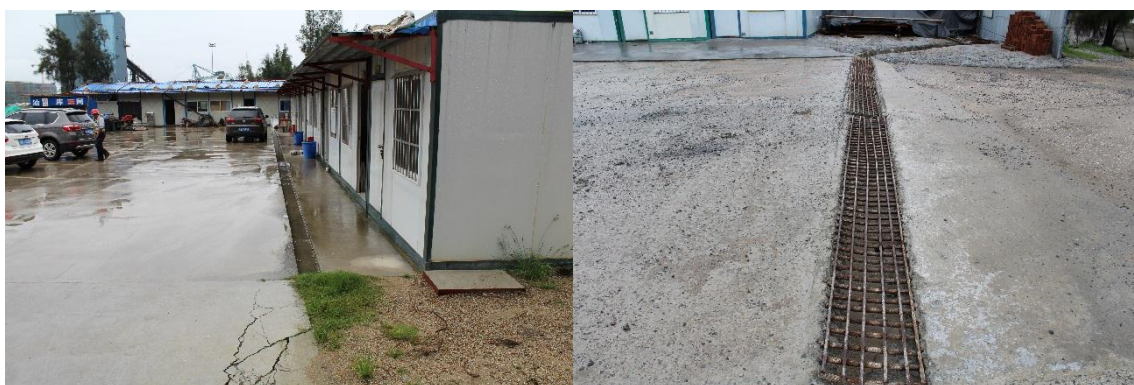
施工场地临时排水沟
