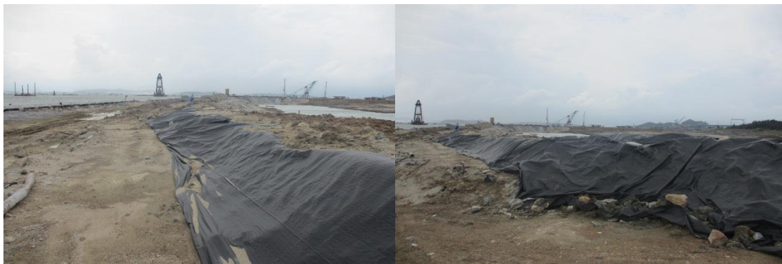
施工期堆土临时覆盖
