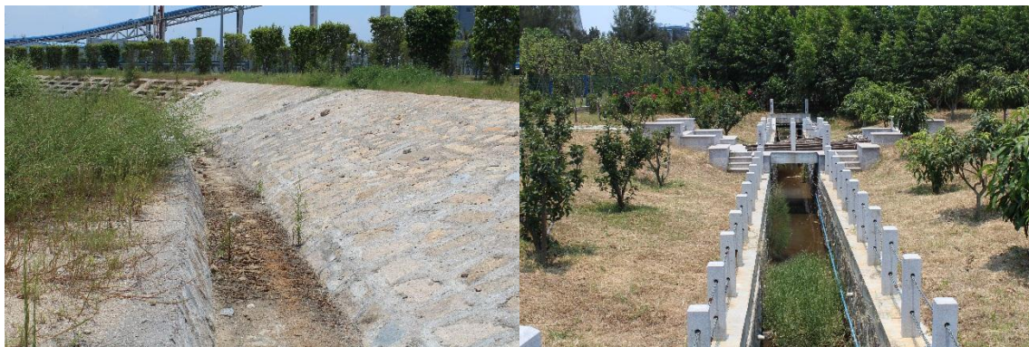
厂外道路工程护坡
