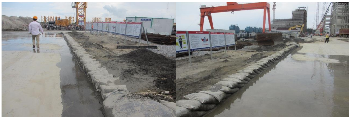
开挖土方临时拦挡
