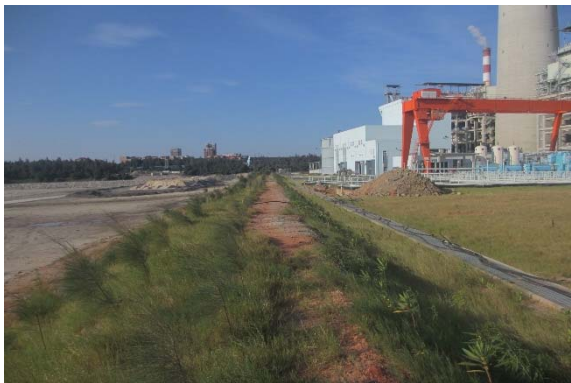
贮灰场边坡绿化
