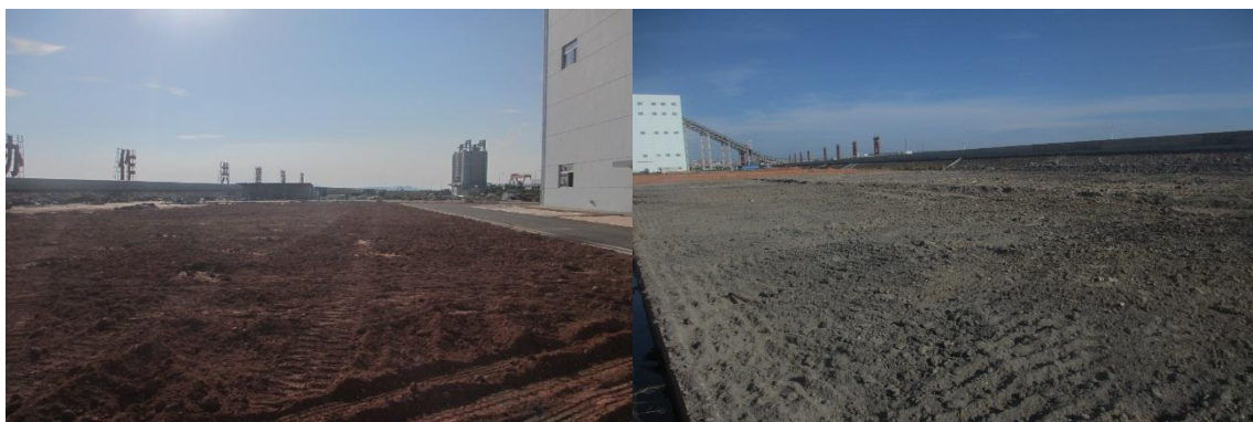
施工场地覆土
