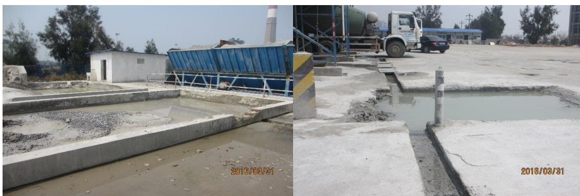
拌合站沉沙池
