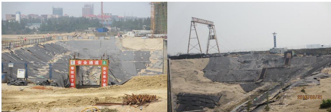
循环水泵房开挖边坡临时覆盖
