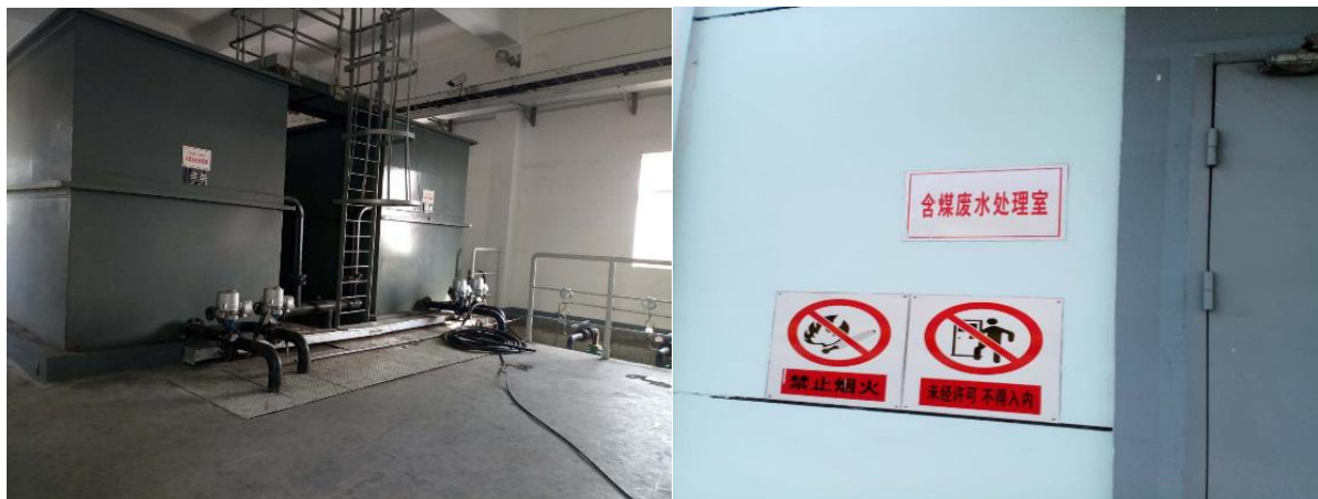
图 4-16 含煤废水处理系统
